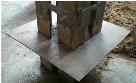
图4 格构柱止水钢板
